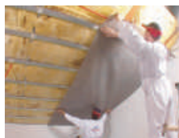
7 Në profilin C me shirit ngjitës të dyanshëm e përforcojmë penguesen e avullit
