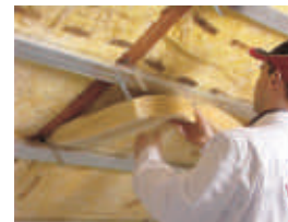
6 Në profilin metalik C e vendosim shtresën e dytë të izolimit
