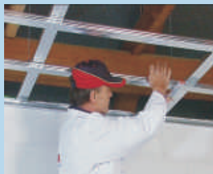
1 Vendosja e konstrukcionit metalik
