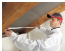
3 Pas matjes së pllakës izoluese e presim atë edhe 1 deri 2 cm më tepër
